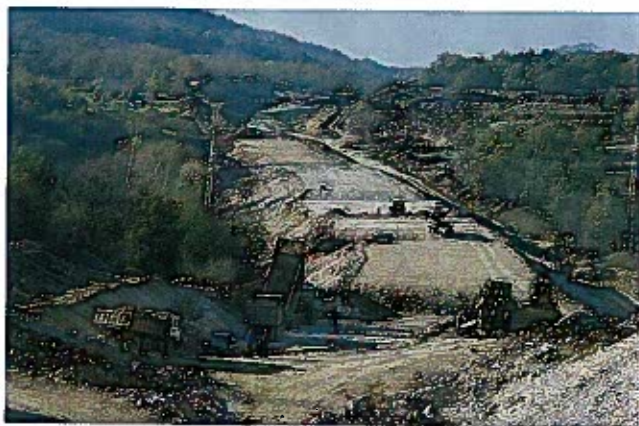
Slika 16 Gradnja ceste v Vipavski dolini
